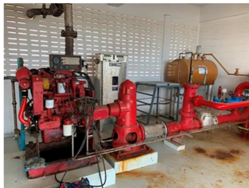
รูปที่ ข-25 เครื่องสูบน้ำดับเพลิง
