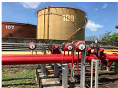
รูปที่ ข-29 ระบบกระจายน้ำดับเพลิงแบบอัตโนมัติ
