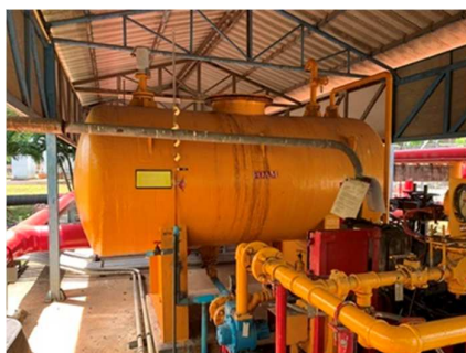
รูปที่ ข-27 ระบบโฟมอยู่บริเวณตรงข้ามกับอาคารทำการนายท่า โดยจะมีท่อโฟมส่งไปที่ถังเก็บน้ำมันทุกถัง
